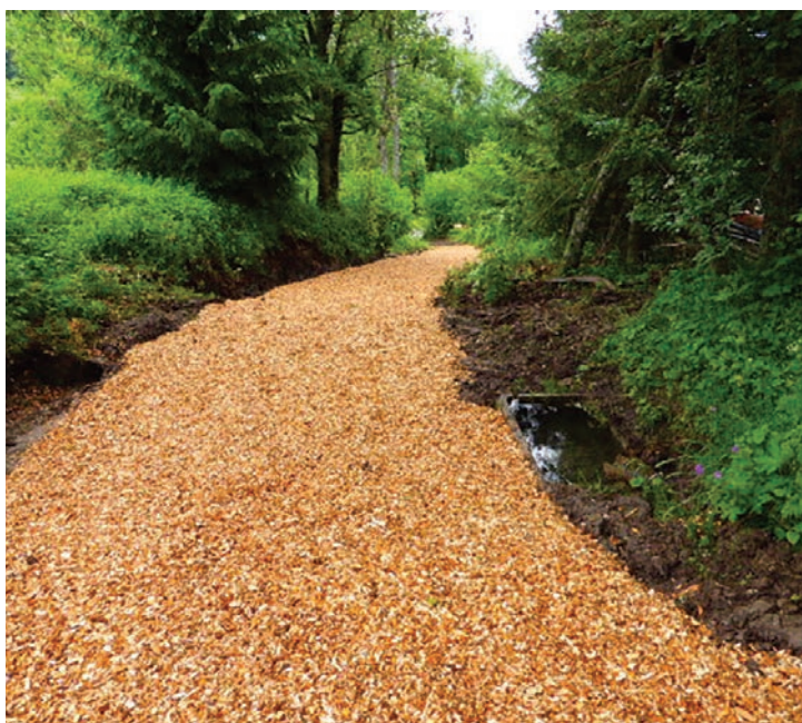
Travaux structurants dépose de copeaux Descente de la Menoge.
