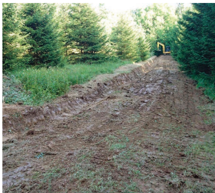
Travaux structurants reprofilage et création de fossé GR Balcon du Léman.
